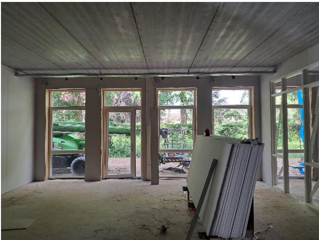
Foto 5: lokaal kinderopvang van met gevel kozijnen
